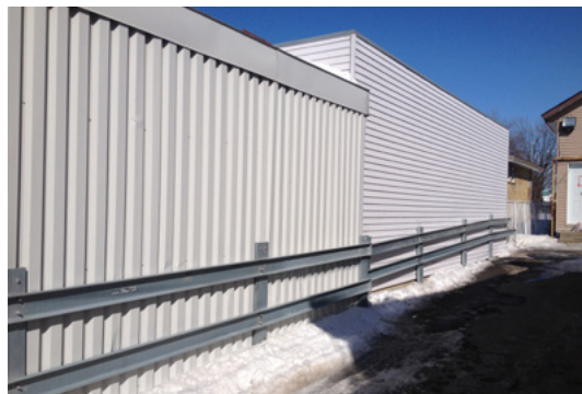
Clôture en acier galvanisé-Galvanized fence
