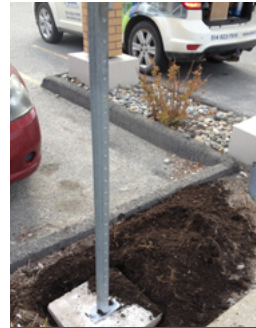
Installation d'affichage- Signs installation
